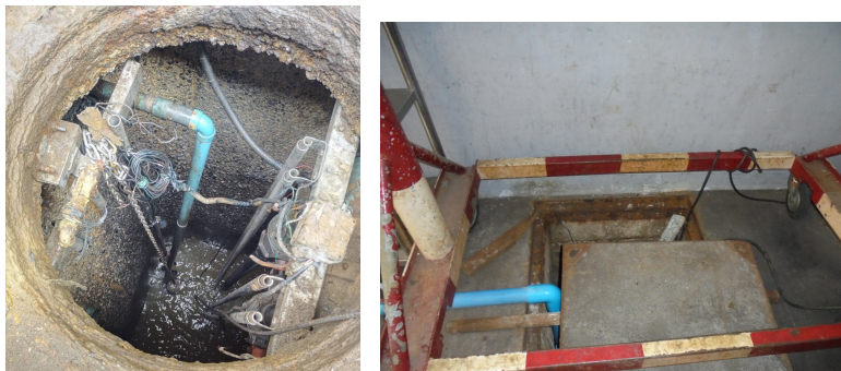
ภาพที่ 3-5 ระบบบำบัดน้ำเสียฝังอยู่บริเวณถนนทางวิ่งของโครงการปัจจุบันปิดซ่อมแซมบำรุงรักษาระบบบำบัดน้ำเสีย
