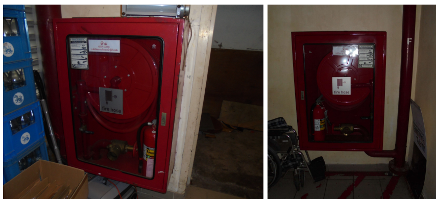
3-14 ระบบท่อเย็นและตู้เก็บสายฉีดน้ำดับเพลิงพร้อมอุปกรณ์
